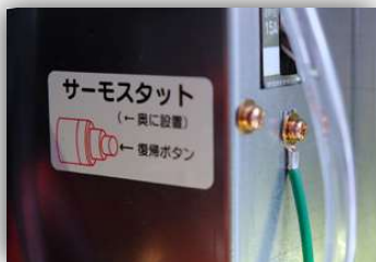
高温異常が発生した際、バーナーを自動停止させます
